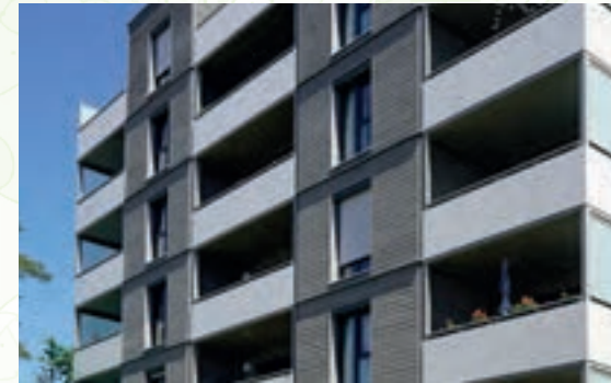
2. Bauabschnitt 2020: Neubau von 140 Wohnungen in fünf Punkthäusern mit je sieben Geschossen
