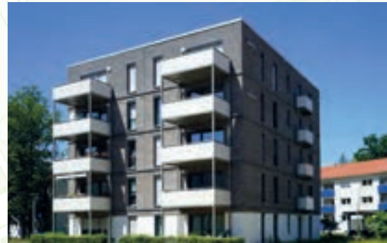
1. Bauabschnitt 2018: Neubau von 39 Wohnungen in drei Punkthäusern mit je fünf Geschossen
