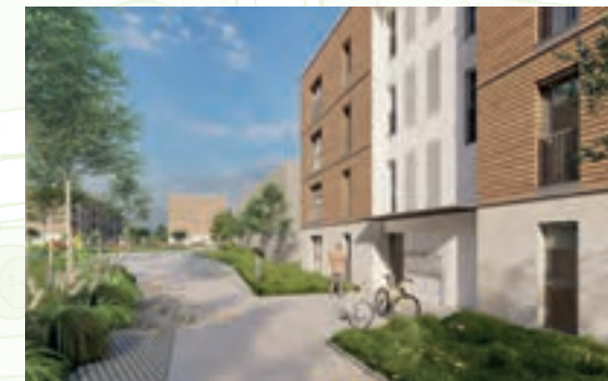
6. Bauabschnitt Neubau von 64 Wohnungen in drei Riegelbauten in Holzhybridbauweise (mit TG)
