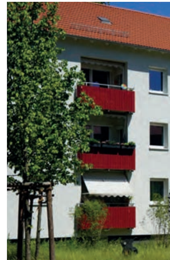
Fassade nach der Sanierung
