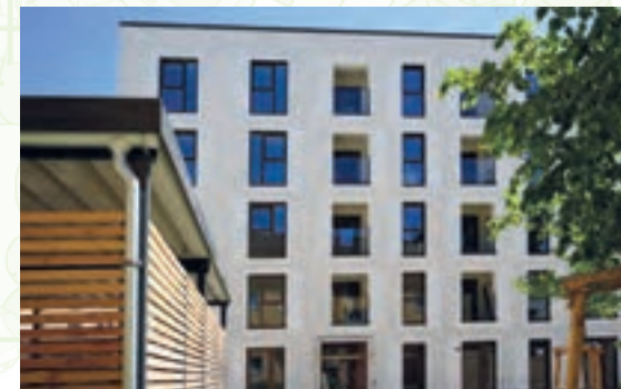
5. Bauabschnitt 2023: Neubau von 168 Wohnungen in vier Riegelbauten mit je vier Geschossen
