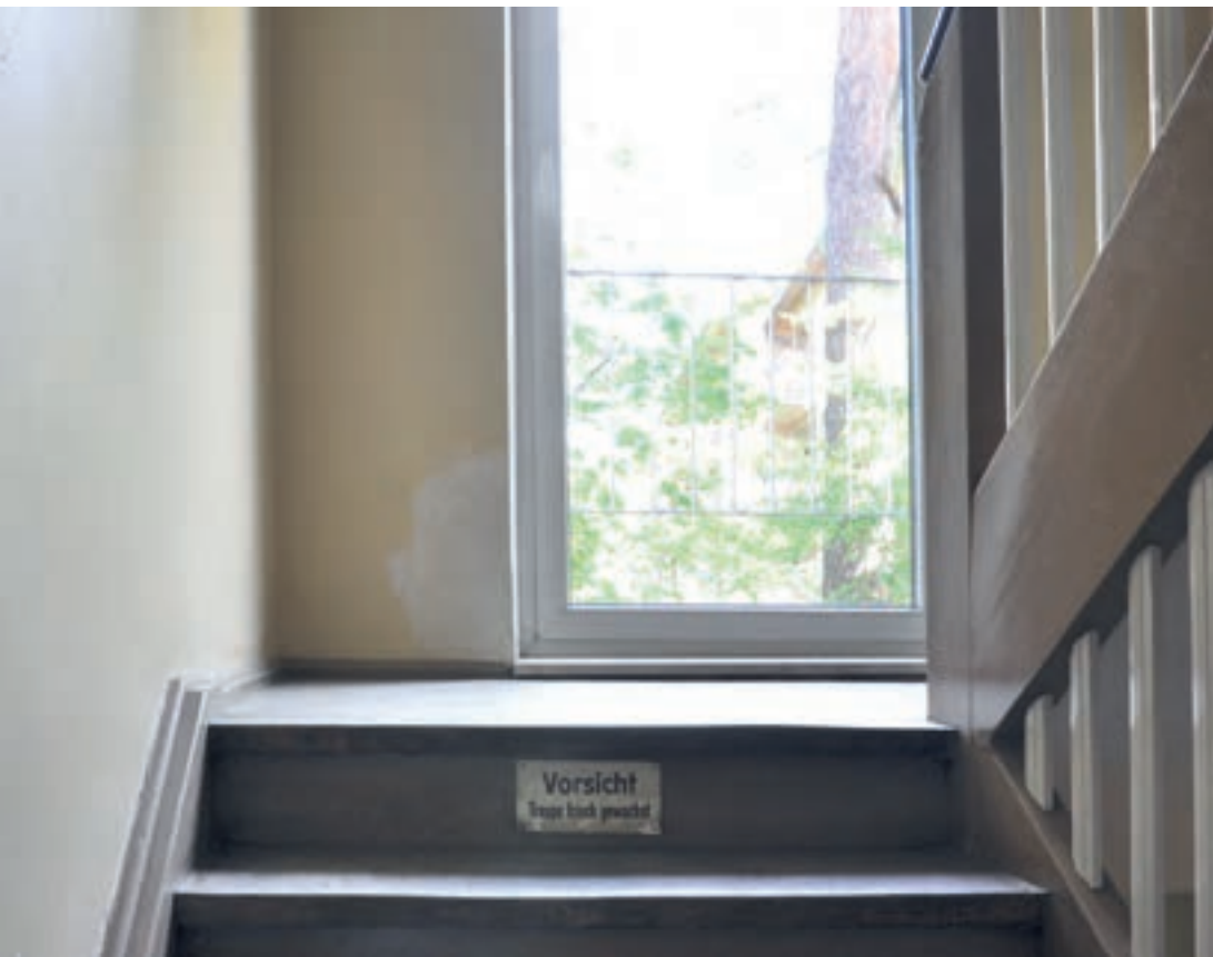
Treppenhaus vor der Sanierung
