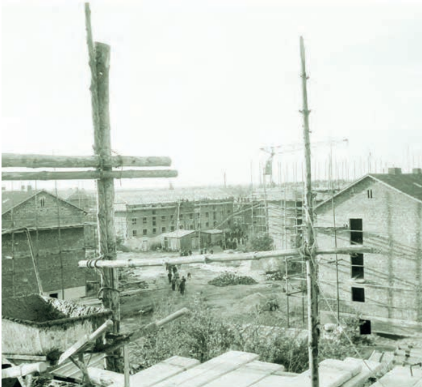
Baustelle Jaminpark mit Holzgerüsten
