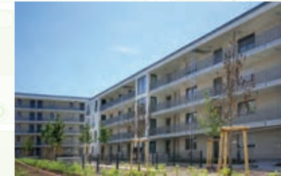
4. Bauabschnitt 2023: Neubau von 152 Wohnungen in fünf Riegelbauten mit je fünf Geschossen
