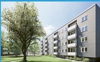
10 Militscher Straße Nürnberg Fertigstellung 2026 72 Wohneinheiten
