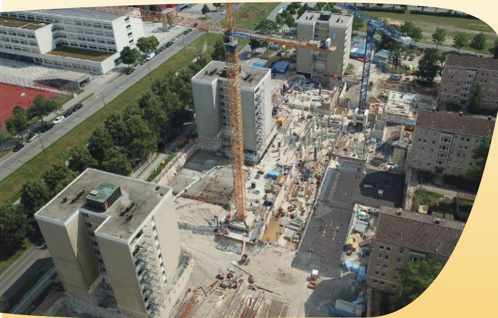
Parallel zum Neubau werden die Modernisierungsarbeiten der Hochhäuser vorbereitet. Der Beginn der Modernisierung erfolgt in der Schleißheimer Straße 501. Das Haus wurde bereits mit einem Gerüst versehen und die Arbeiten der Wärmeschutzdämmung beginnen. Derzeit werden in jeder Wohnung die Aufmaßarbeiten für die neuen Fenster vorgenommen.
